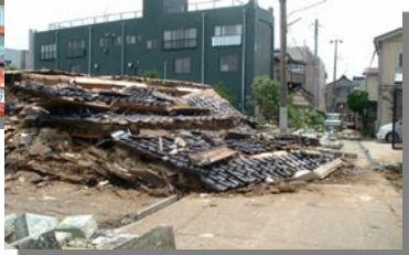
柏崎市内では、真壁で造られた古い家屋、土蔵が数多く全壊又は一部倒壊した。
