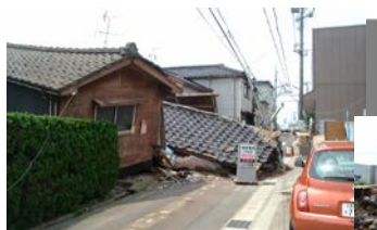
柏崎市内では、真壁で造られた古い家屋、土蔵が数多く全壊又は一部倒壊した。
